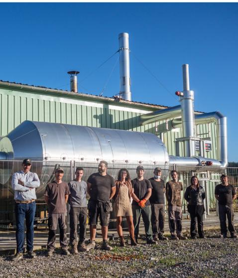
Le principe est simple mais il fallait y penser (et arriver à le rendre rentable !) : récupérer la chaleur dégagée dans le four lors de la cuisson des tuiles pour la stocker dans des cuves afin
