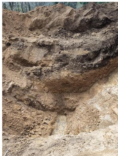
Figure 11 : Sondage réalisé pour retrouver l'emplacement du réseau d'eau potable
