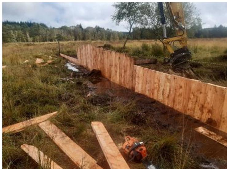
Figure 12 : Exemple d'ouvrage "bouchon" réalisé sur un site similaire par le CEN NA.
